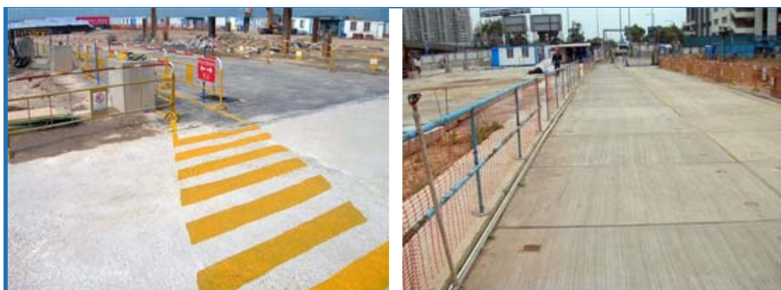
在工地表面以混凝土覆蓋，並劃分行人專區
