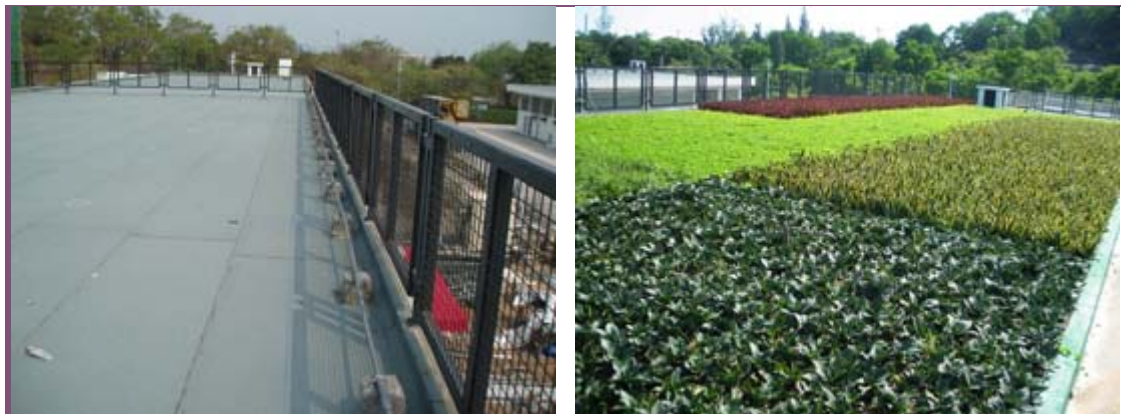
工程前後：屯門政府倉庫屋頂綠化計劃
