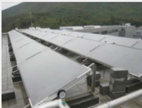
在主翼安裝太陽能熱水供應系統
