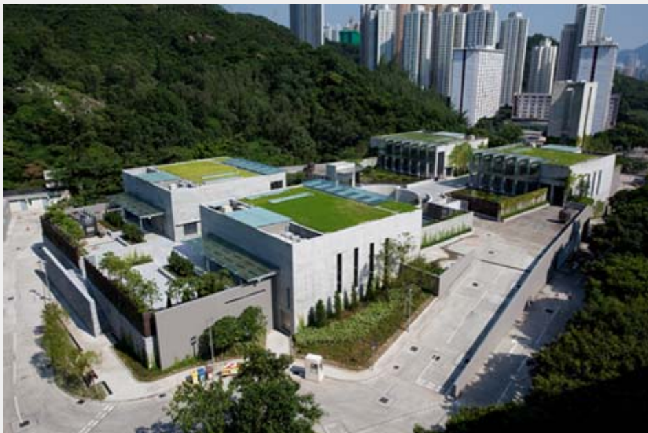
鑽石山火葬場重置工程
