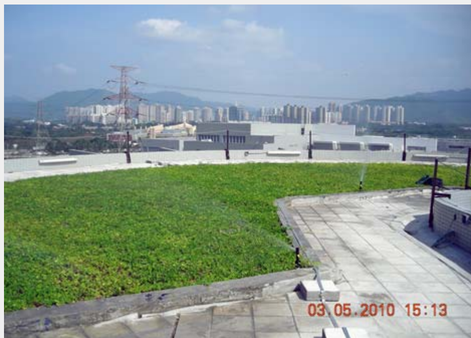
在羅湖懲教所洗盥污水回收系統灌溉植物
