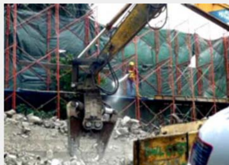
使用液壓碎石機
