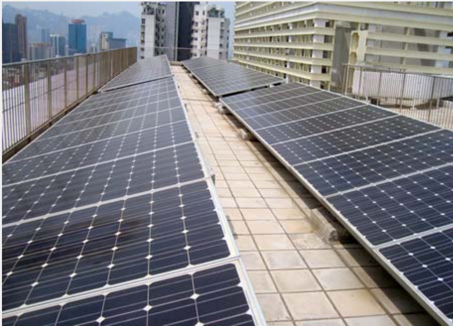
屋頂裝設太陽能光伏板供電
