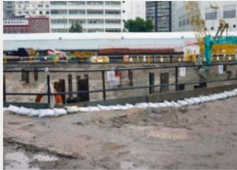
挖掘物料再用作沙包填料和回填物料
