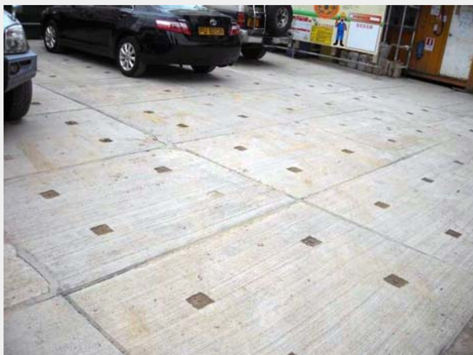
採用混凝土板作臨時鋪路的建築地盤
