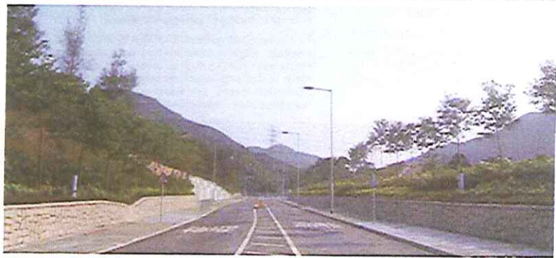
沙田水泉澳及九肚路（沙田水泉澳段）的綠化工程。 Landscape works at Road 1 (Sha Chuen Street), Sha Chuen O, Sha Tin.
