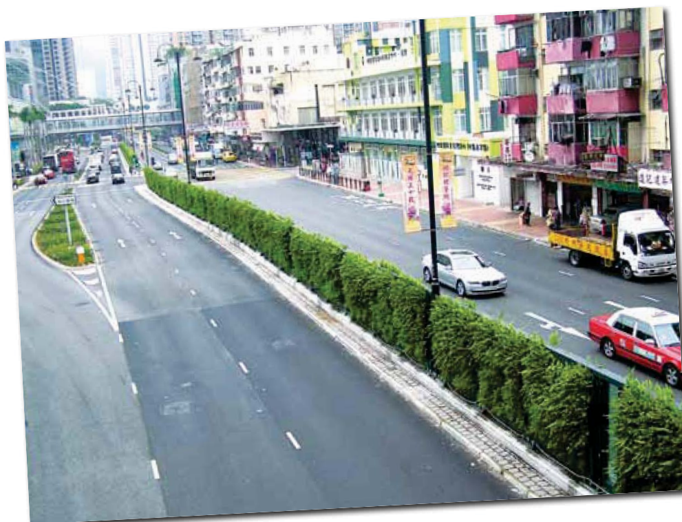
荃灣大河道與馬頭壩道之間一段楊屋道的擴闊工程
