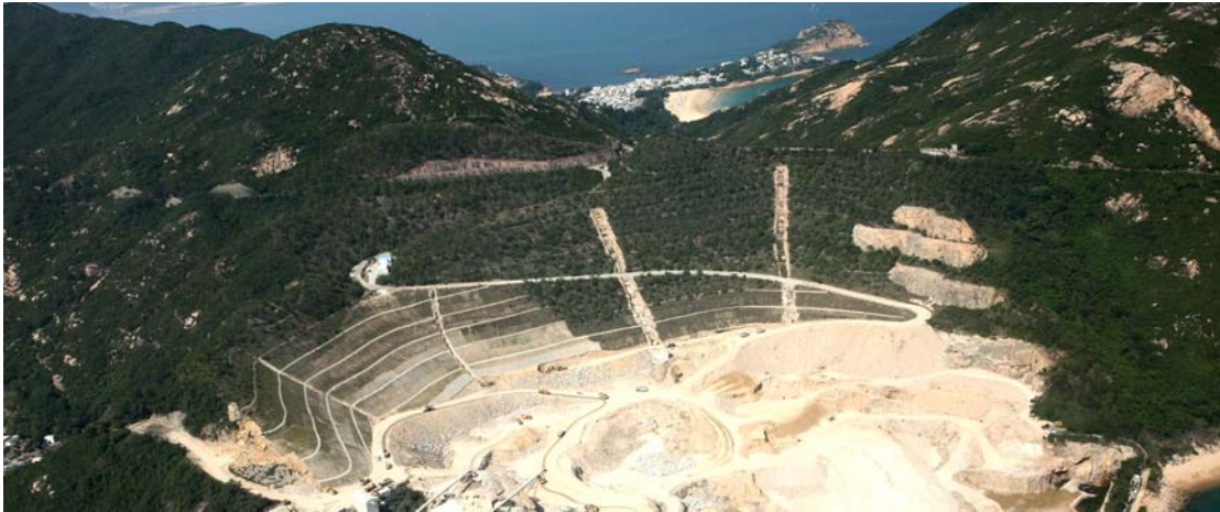
進行中的石澳石礦場復修工程
