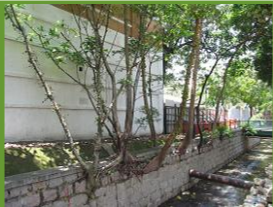
龍珠街明渠石牆樹
