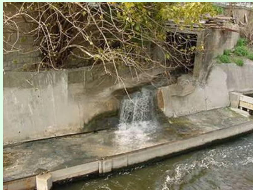
在啟德的旱季污水截流設施把受污染的水流改道流入污水渠
