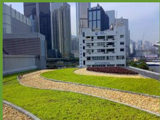
灣仔東污水隔篩廠綠化屋頂
