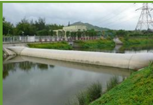
充氣水壩作控制污水和灌溉之用
