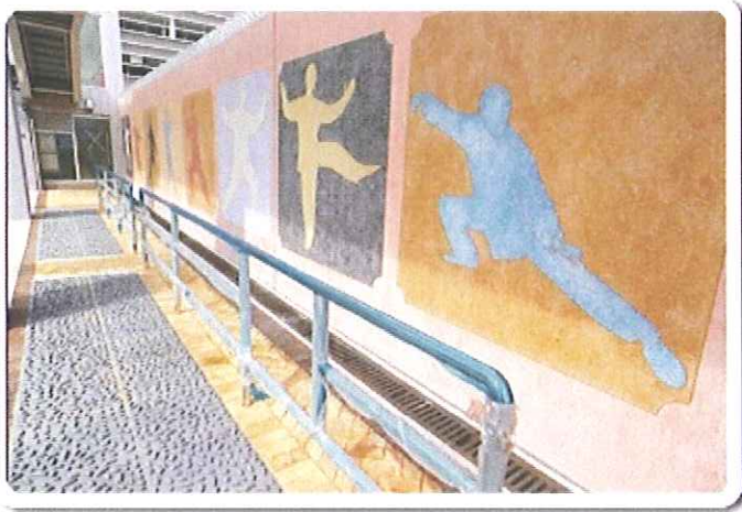
在雨水抽水站上關設的休憩花園
