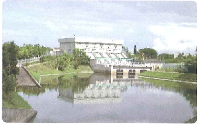
竹園抽水泵房
