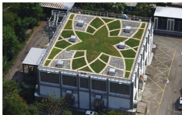
馬鞍山污水泵房的綠化天台
