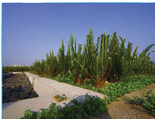
沙田污水處理廠綠化天台的植物
