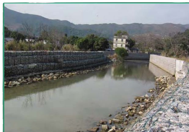
南大嶼山鹿地塘經治理的河道
