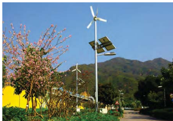
沙田污水處理廠的風力太陽能燈柱
