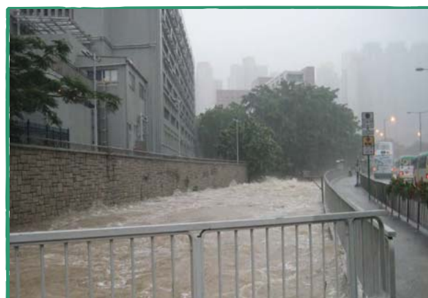
啟德明渠氾濫
