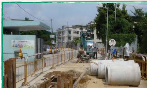
粉嶺永寧村污水收集系統正在施工
