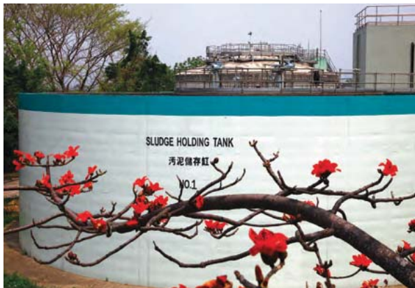
元朗污水處理廠的污泥儲存缸
