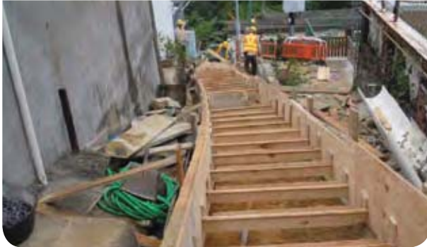
進行中的西貢北港坳村鄉村污水系統工程
