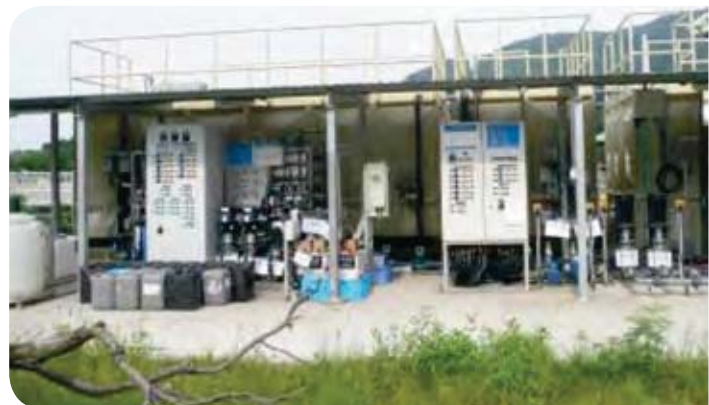
小蠔灣的薄膜生物反應器和逆滲透裝置
