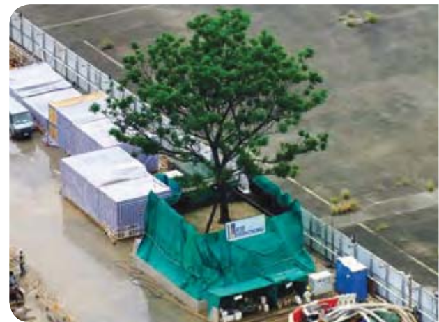
渠務工程中處理需移植的樹木
