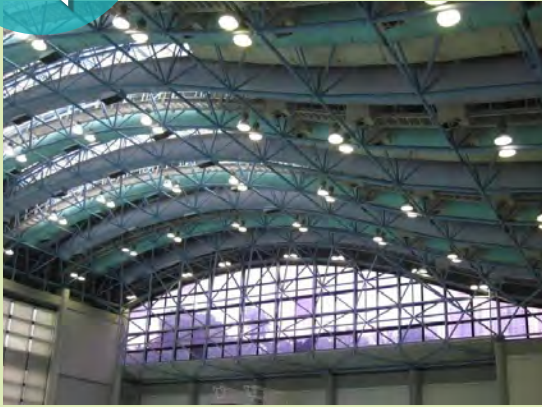
城門谷綜合泳館原有的400瓦特金屬鹵化物照明，已更換為200瓦特的電磁感應燈。
