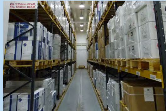
政府物流服務署的卸貨區及二樓儲物區，均安裝了125瓦特發光二極管天井燈。
