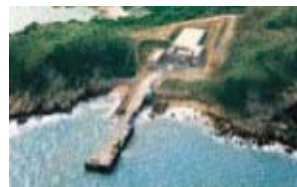
小鴉洲低放射性廢物貯存設施
