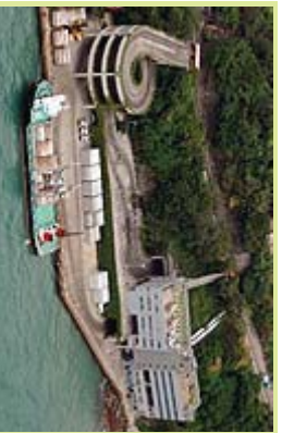
港島西廢物轉運站
