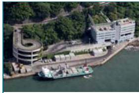
港島西廢物轉運站
