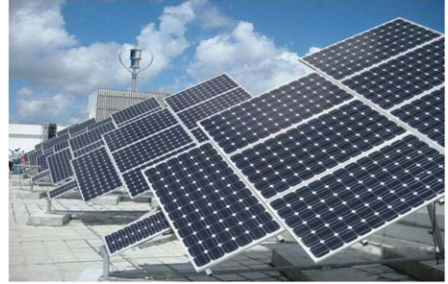
追蹤太陽的單晶硅光伏板
