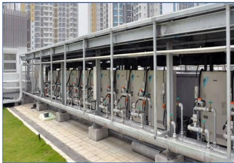
水冷式雙凍量空調系統
