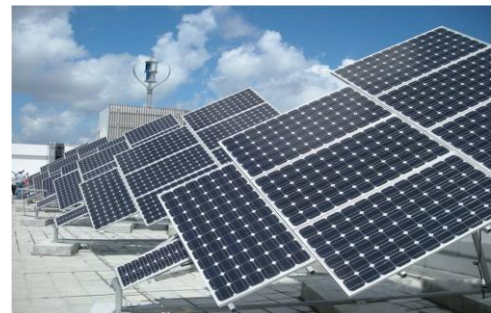
追蹤太陽的單晶硅光伏板
