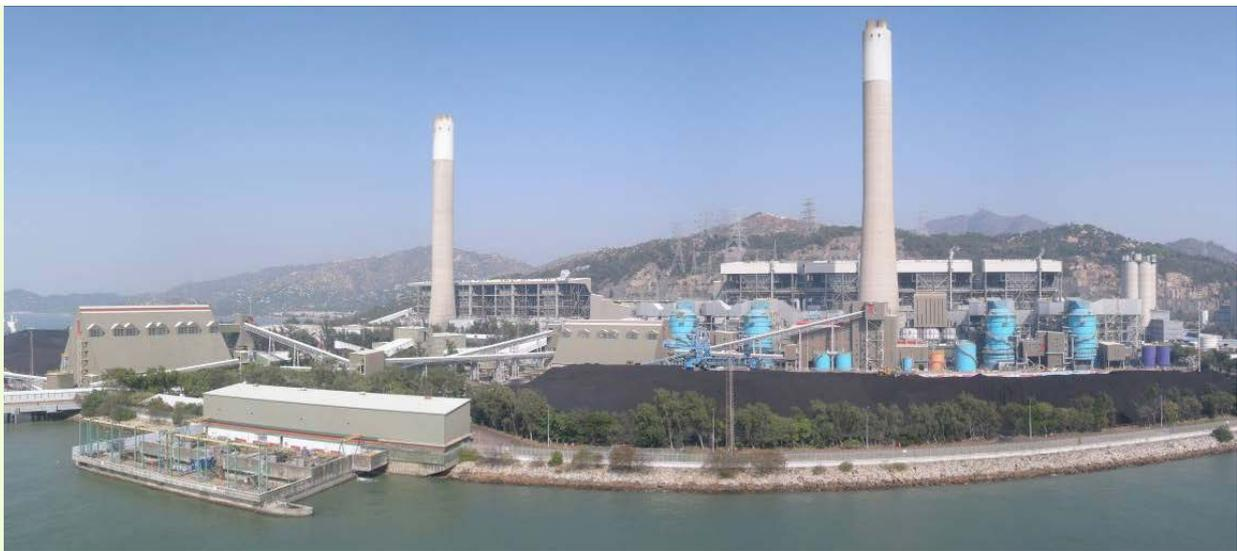
青山發電B廠的燃煤機組已加裝減排設施（相中前景4台藍色設施為煙氣脫硫裝置）- 相片由中華電力有限公司提供。
