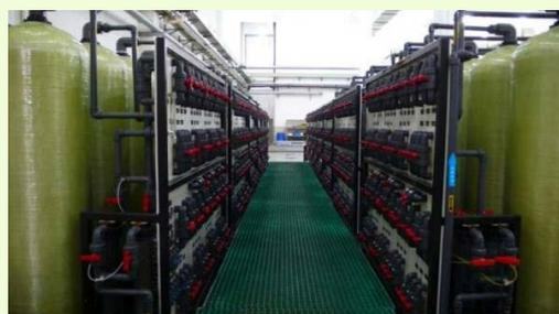
塑膠產品製造廠利用離子交換系統回收沖洗廢水。
