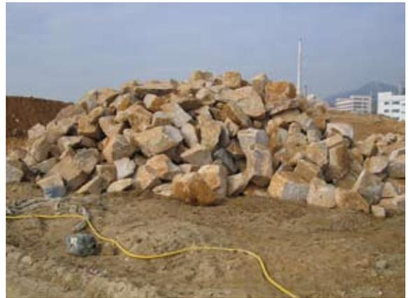
完成削土斜坡工程後揀出質素良好的花崗石以循環再用
