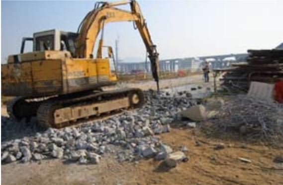
在碎混凝土中揀出鋼筋條
