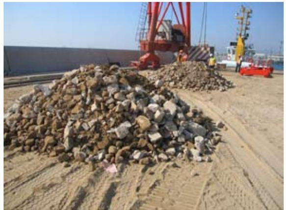
在公眾填土區揀出標稱尺寸200級的循環再造石填料，用以鋪設臨時路底基層
