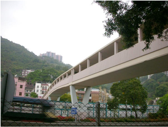
近豐禾里並橫跨大埔公路的行人天橋
