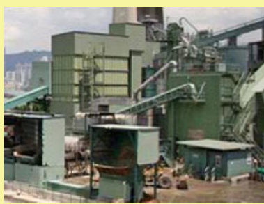
在廠房拌合回收瀝青路面物料和基質瀝青
