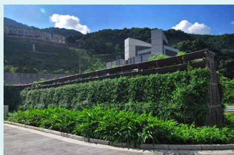
八號幹線的人工土堤
