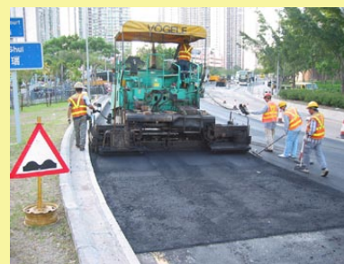
用含有回收瀝青路面的物料鋪路
