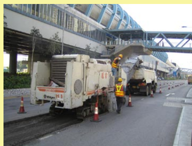
刨去損壞路面
