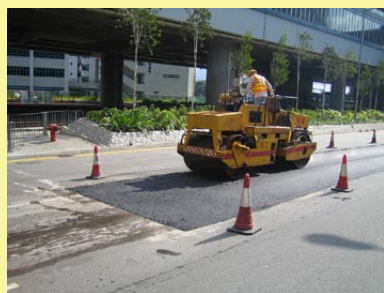
為含有回收瀝青路面物料的路面進行鋼輪滾壓工序
