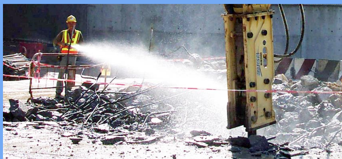
在工地灑水以抑制塵埃
