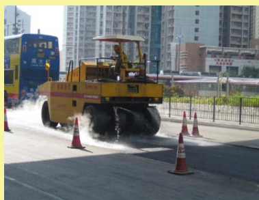
為含有回收瀝青路面物料的路面進行最後的橡膠輪滾壓工序
