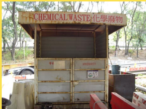
化學廢物儲存設施
