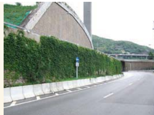
在青山公路（汀九段）旁的綠化護土牆
