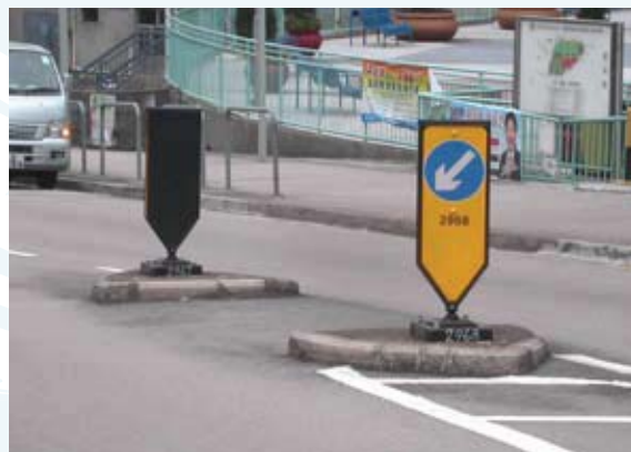
沒有照明裝置的TMP反光安全島標柱
