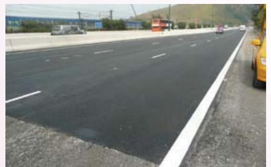
北大嶼山快速公路採用循環再造瀝青重鋪路面
