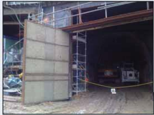
在臨時爆炸品倉庫為隧道工程準備隔音罩
