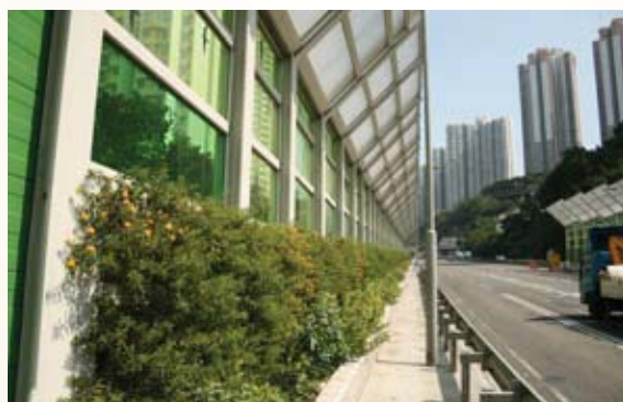
將軍澳道的綠化隔音牆／隔音屏障
