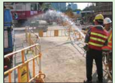
在建築工地實施的塵埃控制措施
