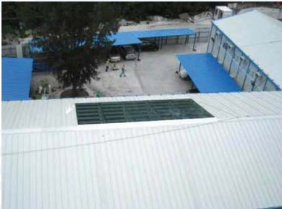
在駐工地總工程師辦事處安裝的天窗
