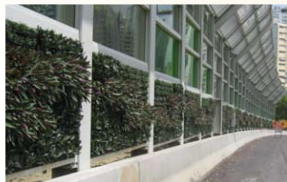
荃灣青荃橋的綠化隔音牆／隔音屏障
