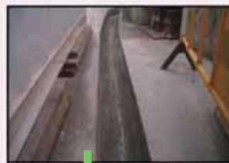
U形排水渠收集地面徑流
