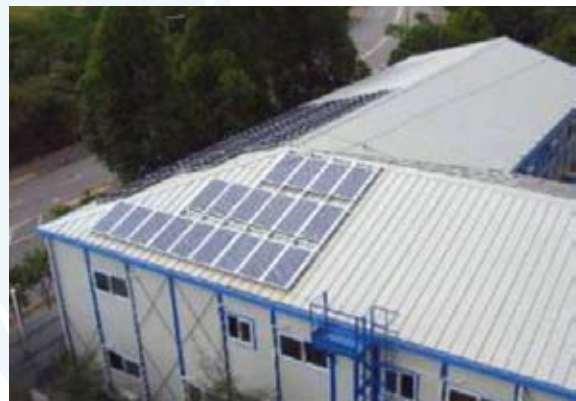
在駐工地總工程師辦事處安裝的光伏能源系統
