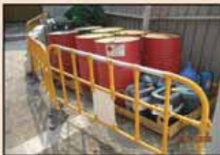
妥善儲存並以圍欄隔開的化學物容器
