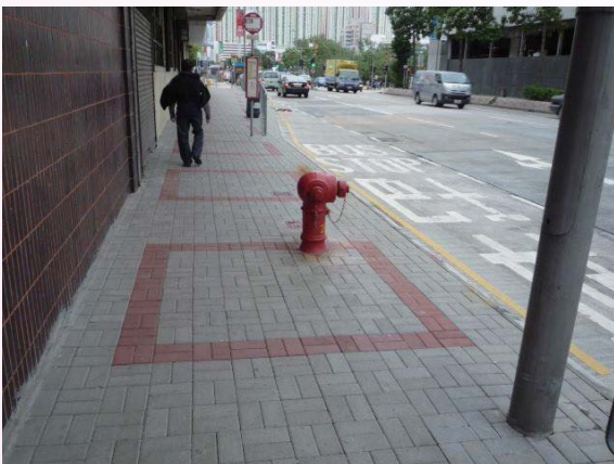
在宏光道上鋪設的含再造玻璃鋪路磚
