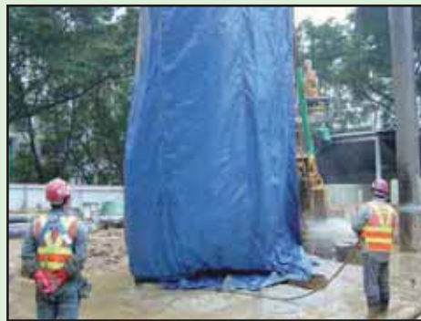
在建築工地實施的塵埃控制措施
