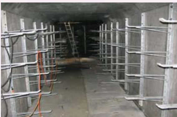
位於海天徑的公用設施共用管道
