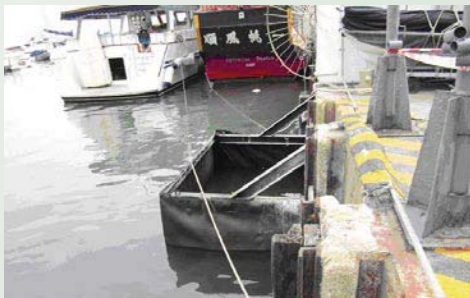
在海水進水口附近安裝隔泥網
