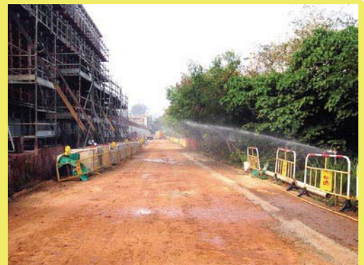
沿運料路安裝灑水系統
