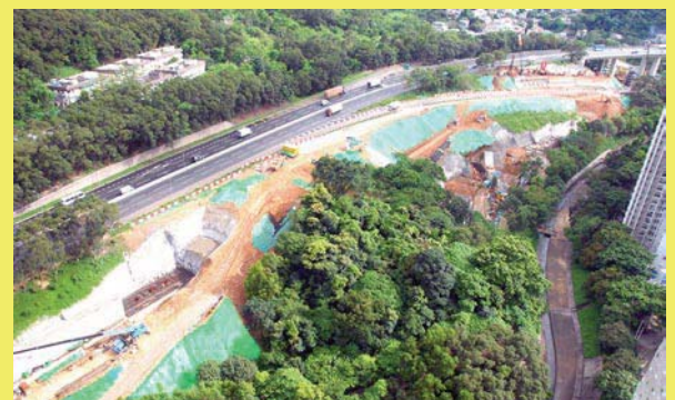
以噴漿混凝土或防水布遮蓋臨時挖掘處的表面
