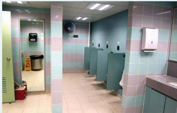
已翻新的洗手間
