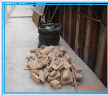
在工地上把拆建物料分類
