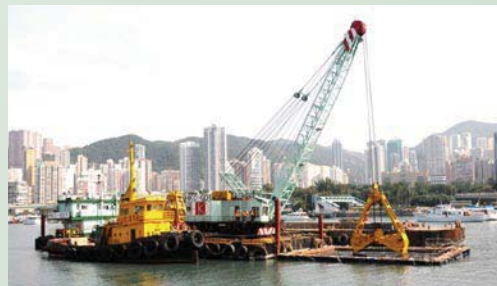
在浚挖區域附近調動隔泥幕
