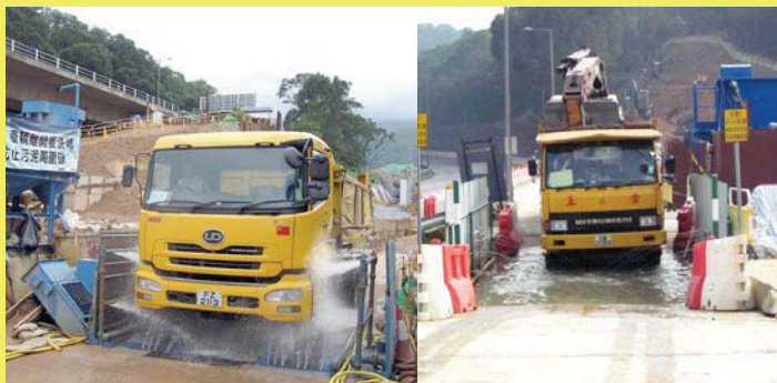
安裝污水處理裝置 (Aquasep) 以清洗車輪
