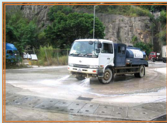
使用裝有噴嘴的水車，以抑制塵埃產生
