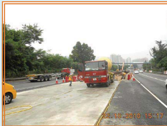
在供地盤車輛行駛的地方鋪上臨時路面
