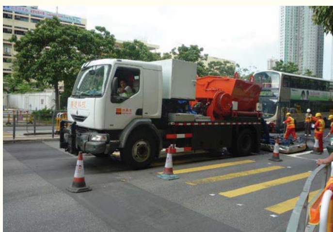
使用較大型熱能修路機應用現場熱拌再造技術的實地測試
