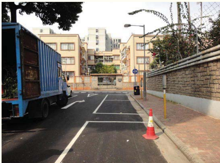
在地鋪路的實地測試中，瀝青物料所含的循環再造瀝青含量為30%
