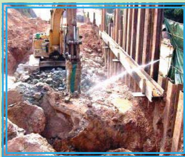
進行混凝土／石頭鑽破工程時在混凝土軋碎機上安裝的臨時隔音圍封
