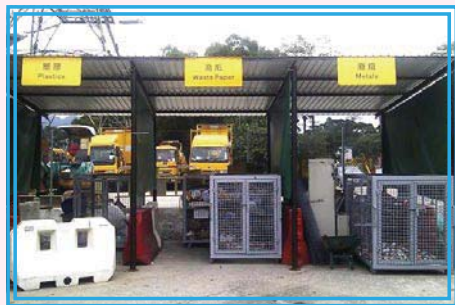
工地上的分類設施及廢物儲存區
