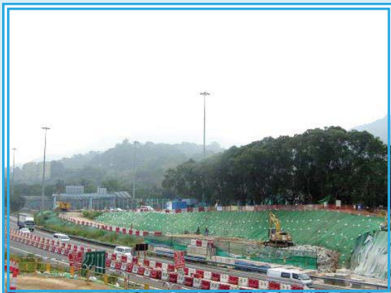
用防水布大規模地覆蓋外露的斜坡
