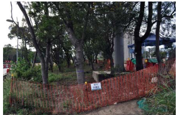
以圍欄分隔工地範圍內受保護的樹木
