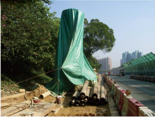
鑽機以防水帆布蓋好
