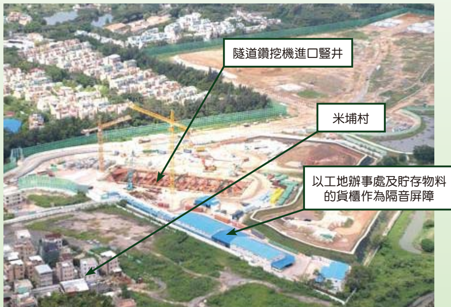
高鐵工程米埔工地概觀
