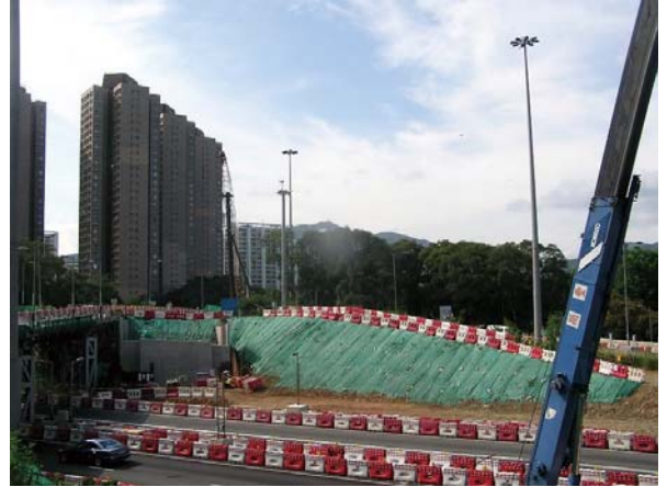
用防水布覆蓋外露的斜坡，以免產生塵埃
