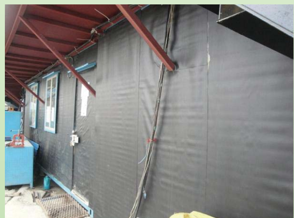
貯物貨櫃裝上吸音物料，以達致最好的隔音效果
