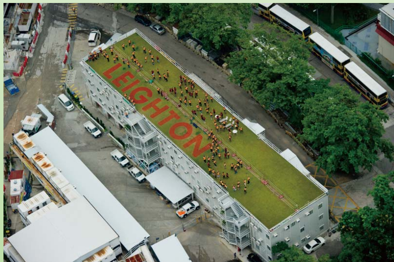
為海洋公園站的工地辦公室提供的綠化屋頂
