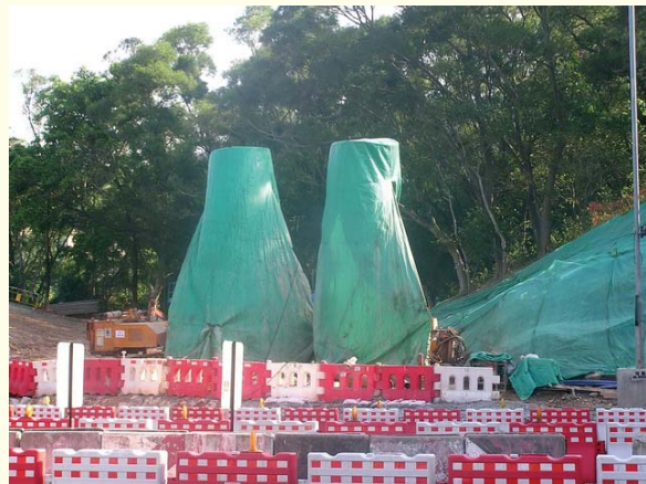
鑽機以防水帆布蓋好
