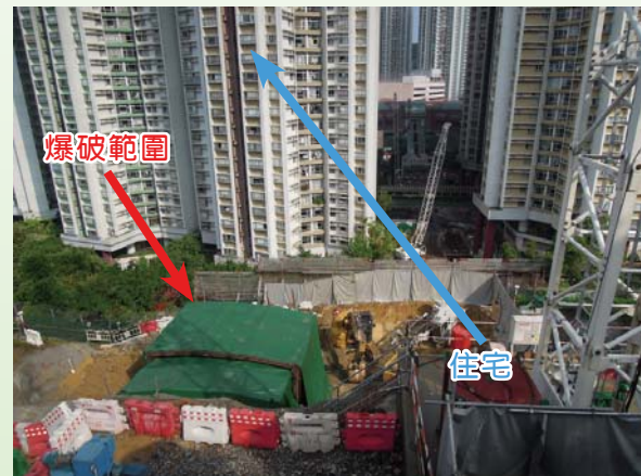
明山爆破以建造黃竹坑車廠及海怡半島通風及機房大樓
