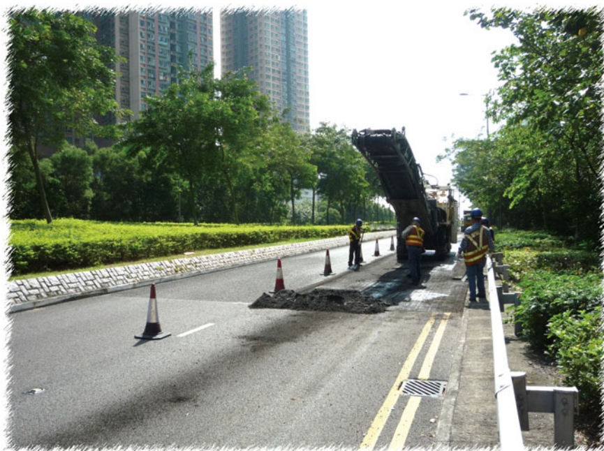
在現有的磨耗層上重鋪聚合物改性多孔面層
