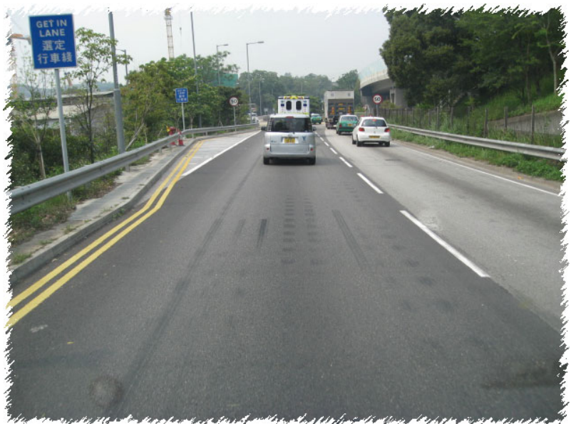
元朗博愛路交匯處路面使用聚合物改性瀝青瑪蹄脂碎石混合物
