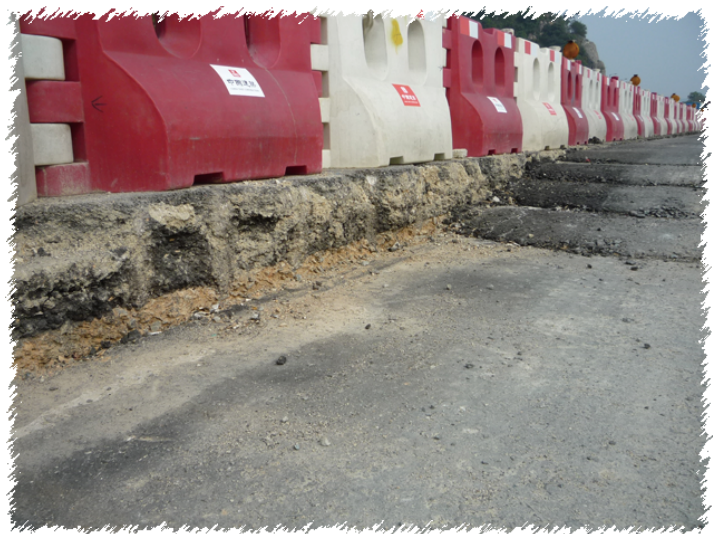
施工中的瀝青路底
