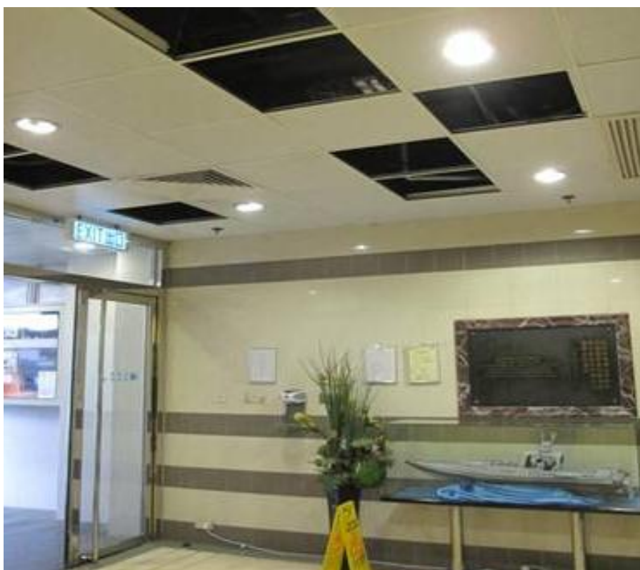
照明燈更換為發光二極管節能燈
