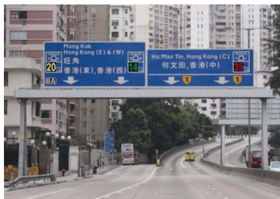
擬於窩打老道南行線（九龍醫院附近）安裝的 行車時間顯示器
