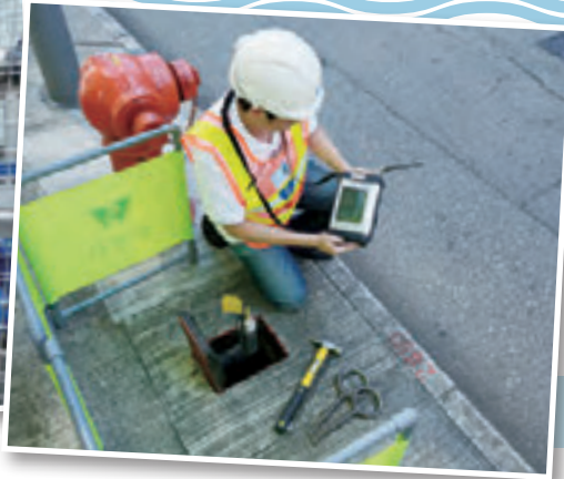
水管滲漏檢測 Leak detection
