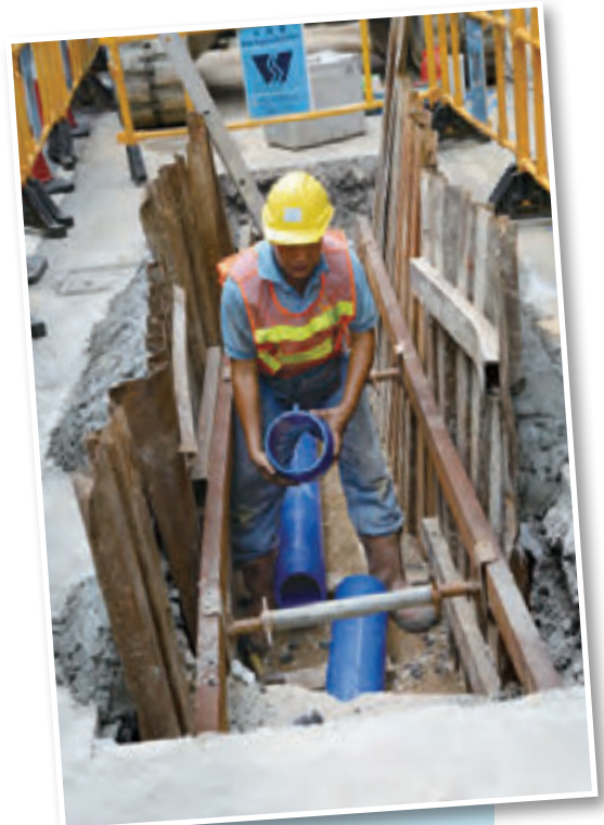
水管更換工程 Pipe replacement work
