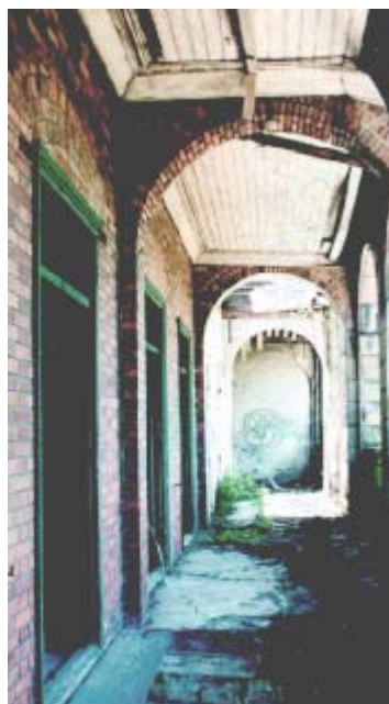
復修前的走廊。
