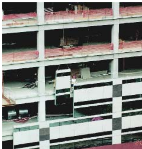
工地進行組合式幕牆系統安裝。
