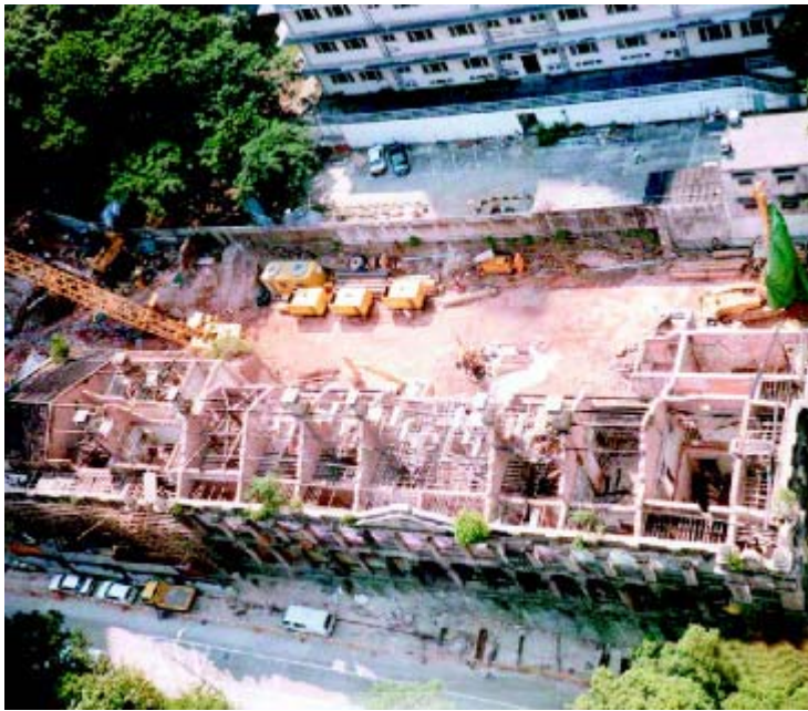
復修工程進行中。
