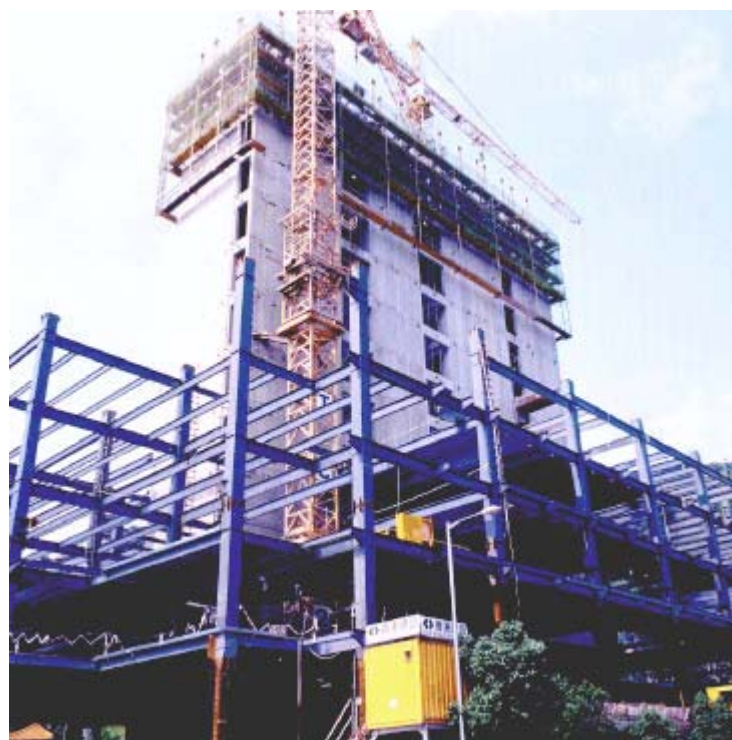
混合結構系統興建中。
