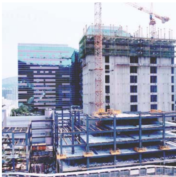
混合結構系統以混凝土作中心的主力牆及鋼材作大樓其他位置的主結構。
