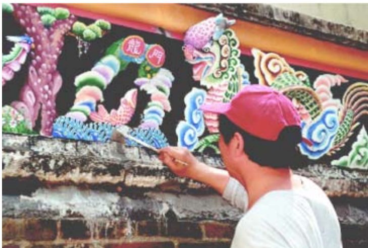
工人正復修外牆的浮雕壁畫。
