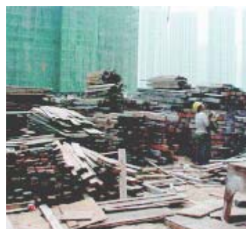
木材模板收集後循環使用。
