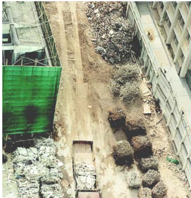
拆卸警察總部 — 工地推行建築廢料分類
