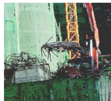
收集鐵筋循環再用。
