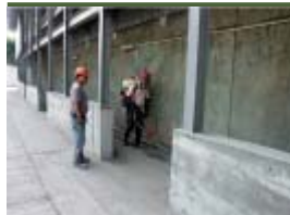
在工地周圍使用噴射式氣霧滅蚊劑
