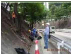
建築署職員進行斜坡檢查
