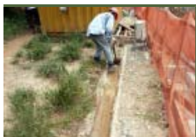
清除工地明渠的堵塞物
