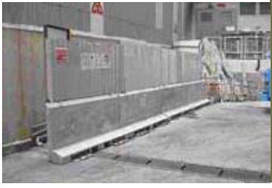
大量採用預製混凝土路面版和圍板
