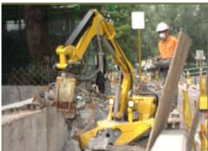
使用氣動混凝土軋碎機，減少噪音污染
