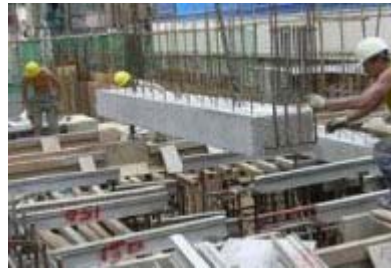
樓面的建造，大量採用預製混凝土組件
