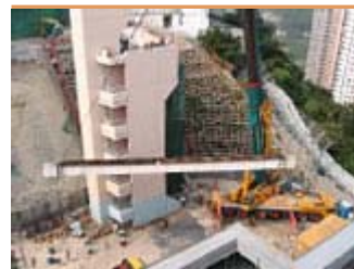
在拆卸項目中需要注意起吊事項
