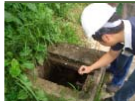
建築署職員檢查沙井
