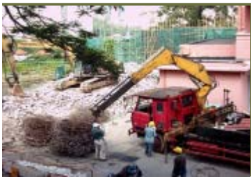
拆卸廢物分類，以便回收再用
