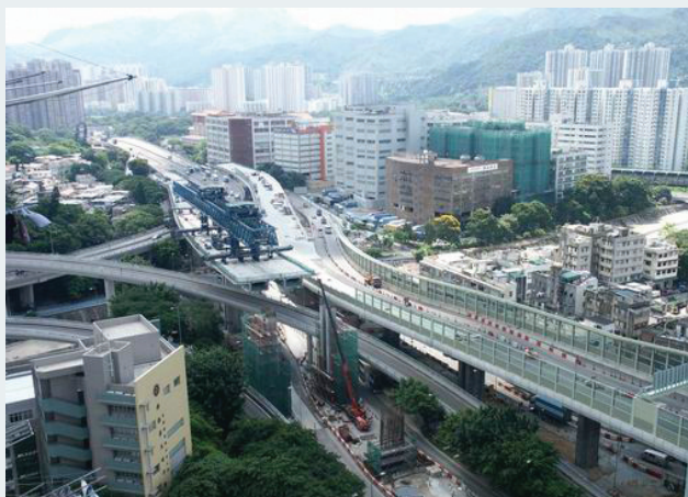
T3號道路 - 預製及預先裝嵌式建造 Road T3 - Precast and Pre-fabricated Construction
