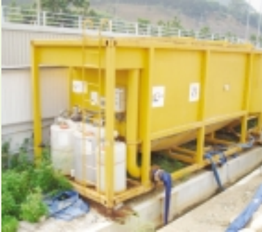
利用沉澱池處理地盤產生的廢水 Sedimentation tank to treat the wastewater generated on site
