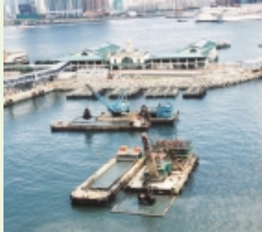
疏浚工程在淤泥屏障內進行 Dredging within the silt curtain
