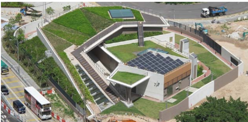
九龍城一號污水 泵房的綠化天台 (相片來源： 渠務署)
