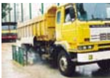
離開工地前洗淨車輪
