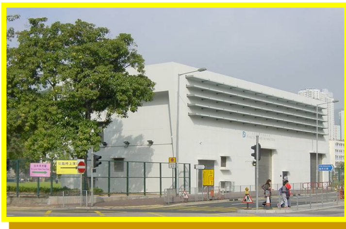
位於西九龍的大坑東抽洪站有助解決水浸問題。
