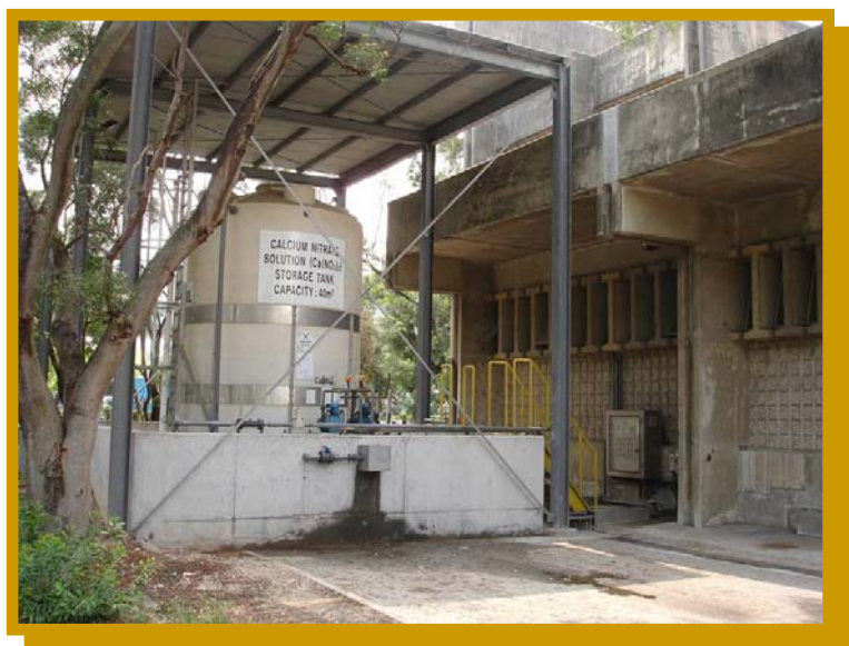
在沙田污水處理廠使用硝酸鈣溶液，減低氣味。
