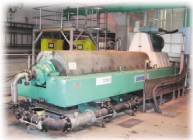
昂船洲污水處理廠具節省能源特點的新型離心機
