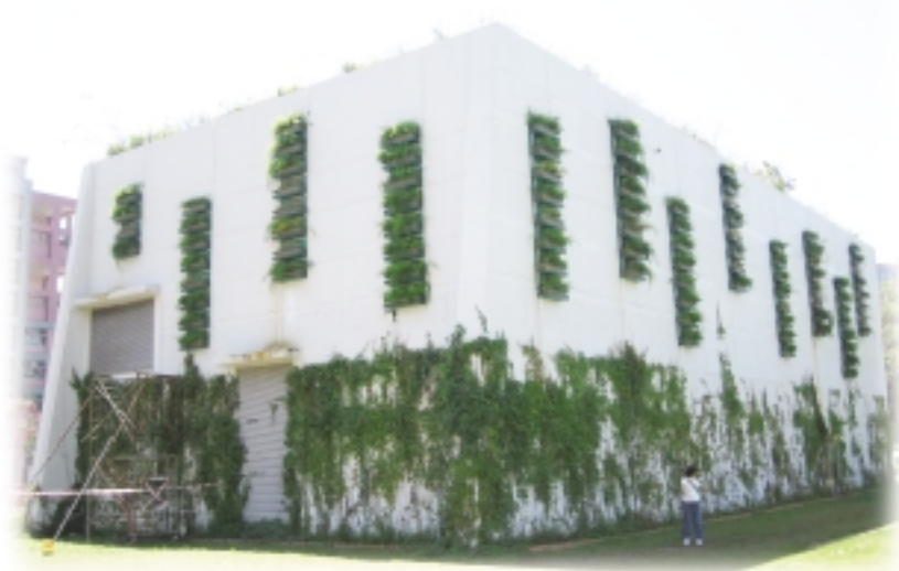
大坑東抽水站的綠化情況
