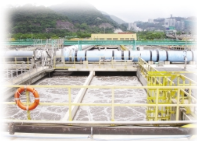
沙田污水處理廠採用更具效益的曝氣系統
