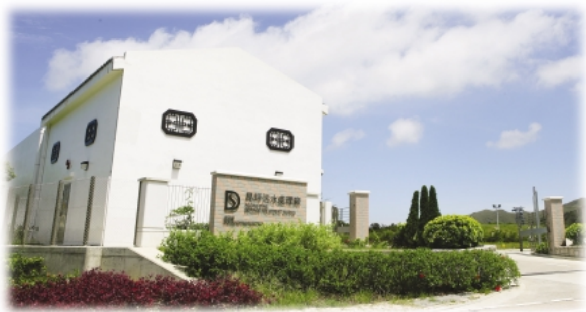
位於昂坪的附設有再造水設施的三級污水處理廠
