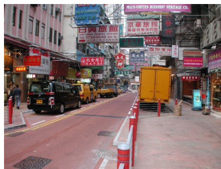
庇利金街 (行人路擴闊及街道美化工程)
