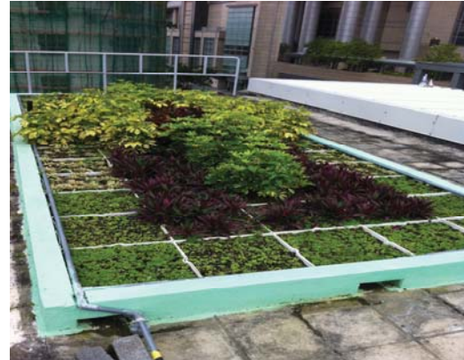
荔枝角消防局的天台綠化工程
