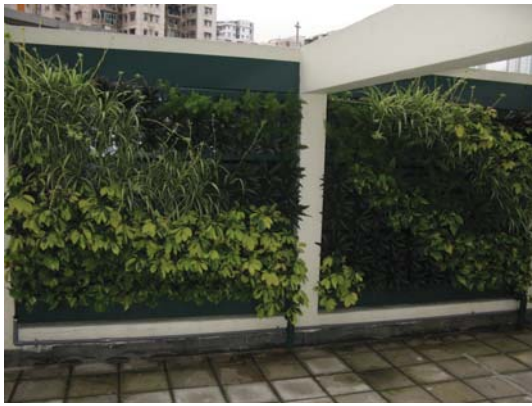
觀塘消防局的天台綠化工程
