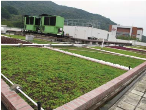
薄扶林消防局的天台綠化工程
