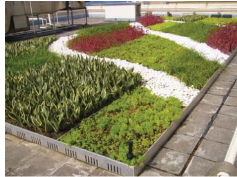
柴灣消防局的天台綠化工程
