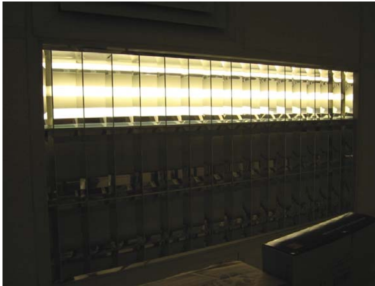
拆除辦公室和走廊的熒光燈管
