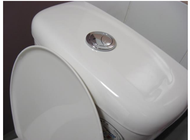
具節約用水效能的坐廁沖水裝置
