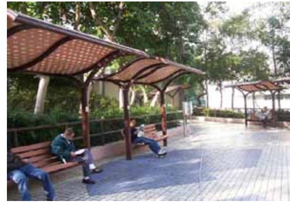
觀塘區 協和街與雲漢街交界休憩處 改善工程
