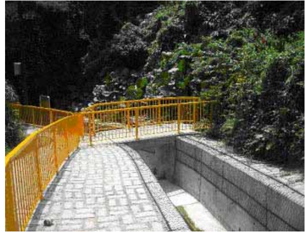
荃灣區 排棉角村明渠建造工程
