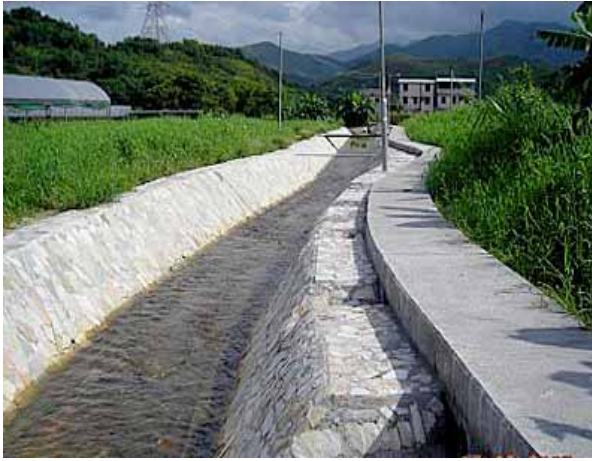
北區 粉嶺鶴藪排行人路及河堤改善工程
