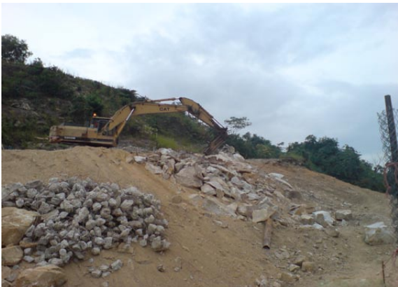
在削土斜坡工程中把基岩和混凝土打碎，以便在工地內循環再用
