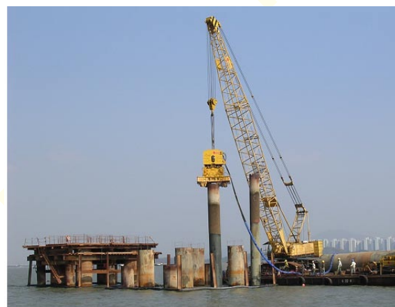
利用臨時橋進行海上鑽孔樁工程
