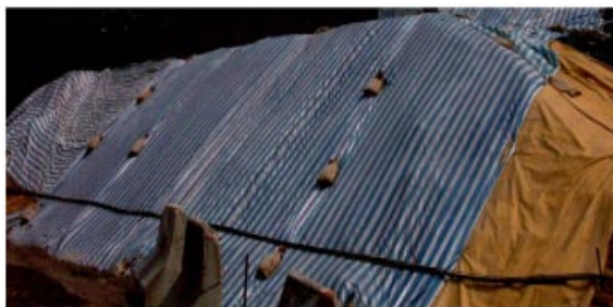
遮蓋露天存料堆／臨時斜坡
