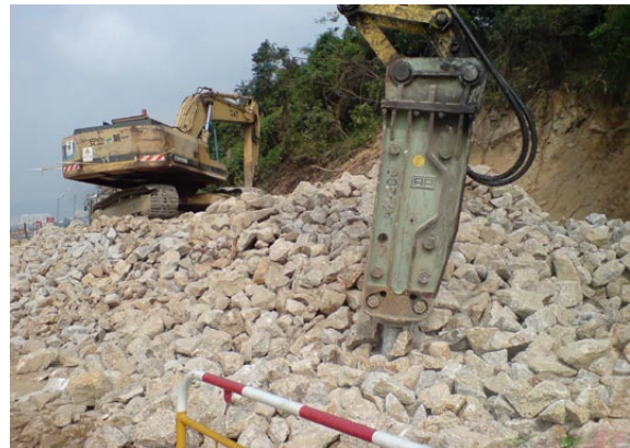
第二次碎石：把岩石和混凝土打碎為標稱尺寸400級的碎石
