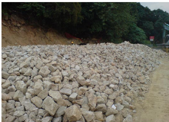
循環再用已打碎的岩石和混凝土，以建造石填料斜坡
