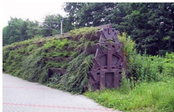
以連鎖堆垛系統造成的土堤
