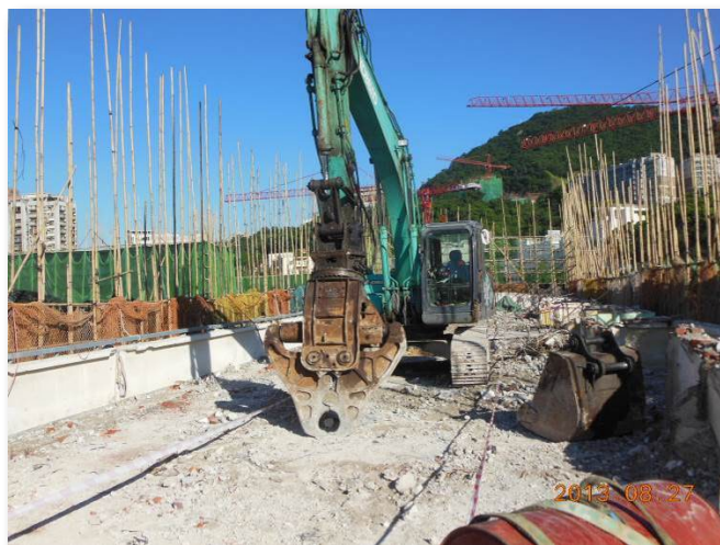
於工地採用液壓混凝土壓碎機
