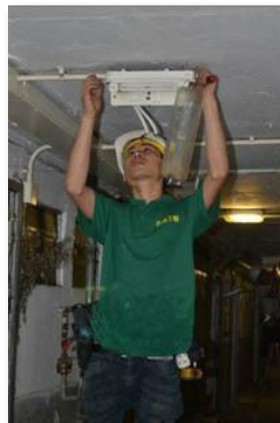
安裝節能電子鎮流器
