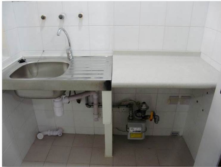
高分子聚酯樹脂灶台設有三段高度可供調校
