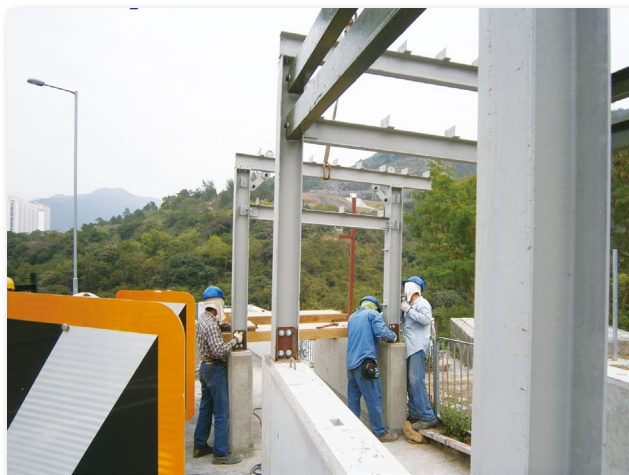
安達臣道地盤的可再用組件式圍板
