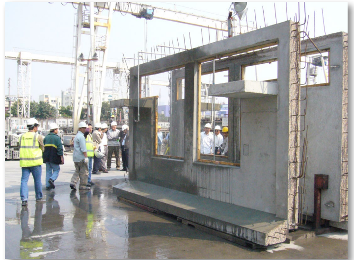
預製混凝土外牆以礦渣微粉取代部分水泥
