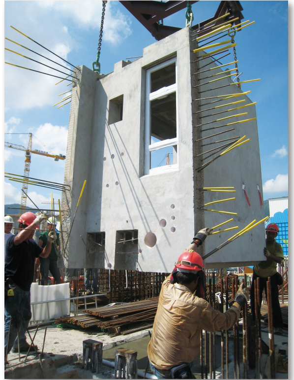
啟德第一乙區的立體預製浴室
