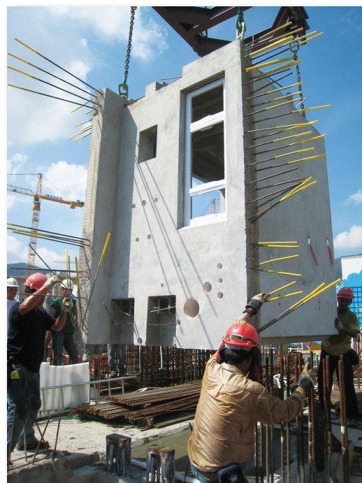
啟德第一乙區的立體預製浴室
