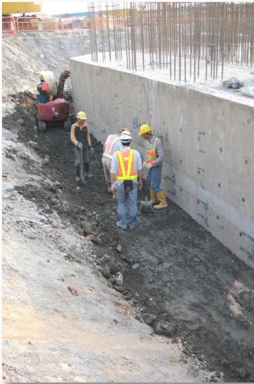
以水泥加固的海泥作回填物料
