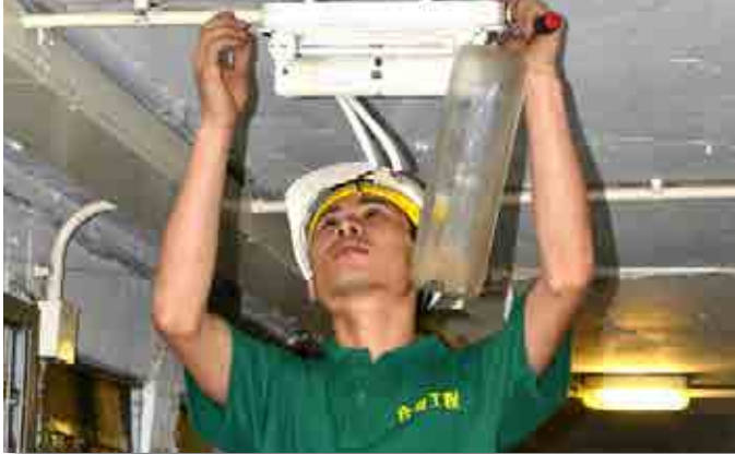
愛民邨安裝使用電子鎮流器的凸面照明裝置
