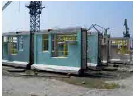
使用預製混凝土組件
