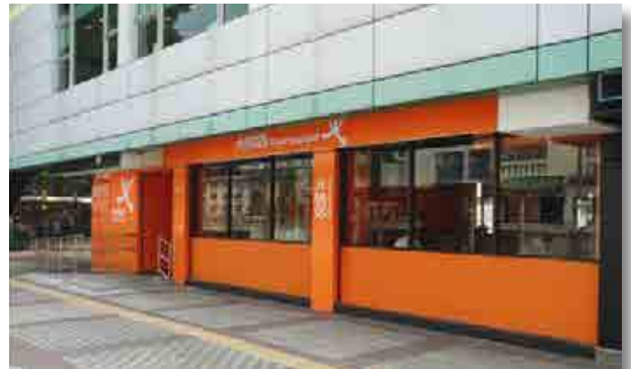
華富(一)邨改善工程
