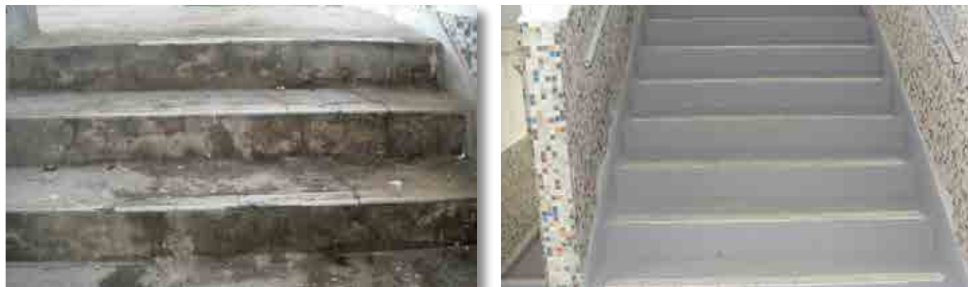
華富(一)邨進行修理及改善工程：施工前(左)及施工後(右)
