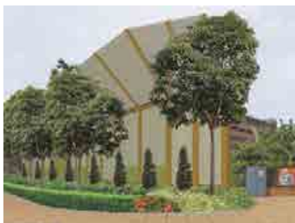
建造隔音屏障在傳播路徑降低噪音
