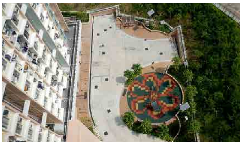
葵涌大白田街新建斜坡的綠化工程
