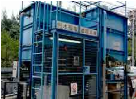
強制安裝污水循環處理設施
