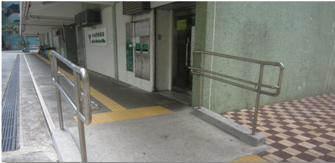
小西灣邨的無障礙通道改善工程
