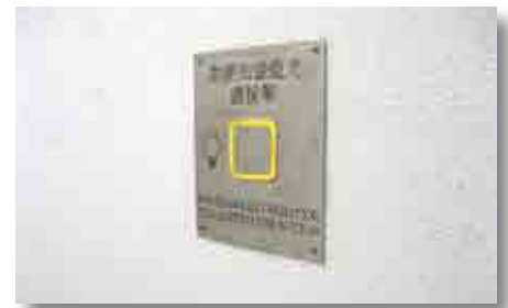
兩級光度照明控制系統的手動開關按鈕
