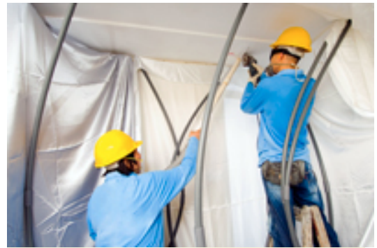
全方位維修計劃著重主動進行室內檢查及維修
