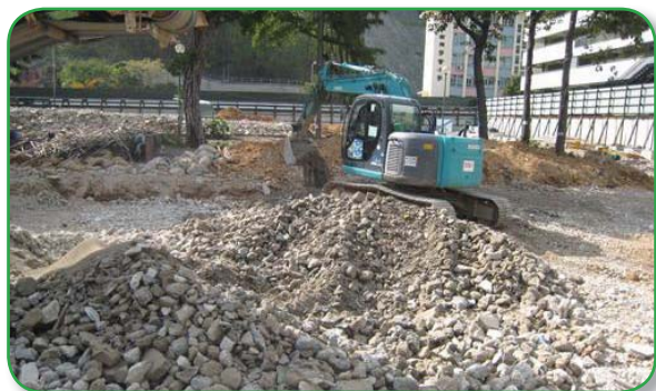
拆卸工程回收的砂石用作回填料
