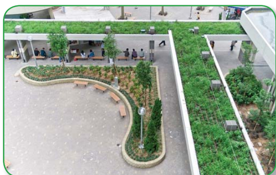
建築地盤的垂直式綠化圍板
