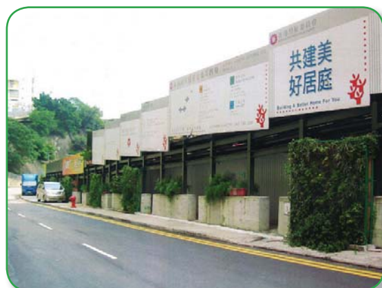
建築地盤的垂直式綠化圍板
