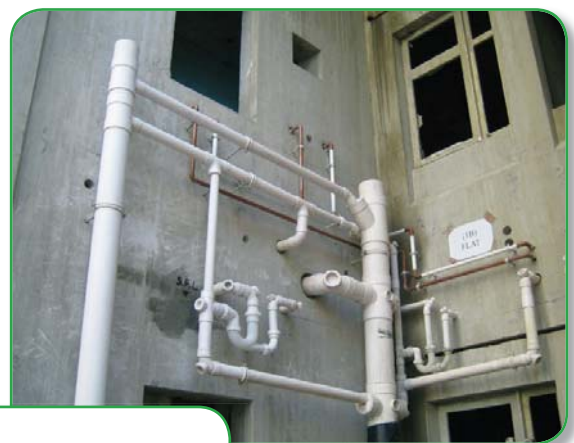
在樓宇安裝「共用W型聚水器」
