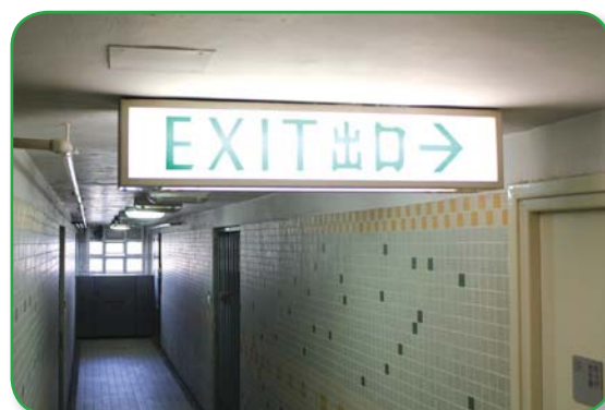
將指示牌的T8光管更換為較節能的T5光管
