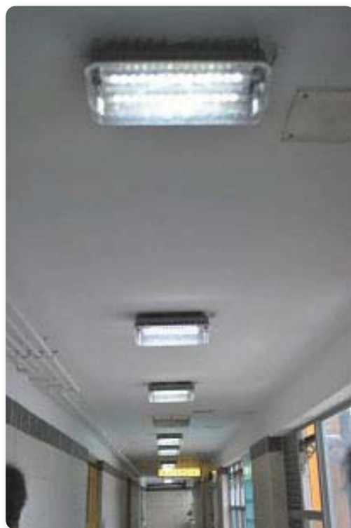
走廊安裝LED凸面照明器
