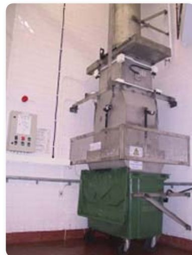
垃圾處理系統的容量控制及儲存裝置
