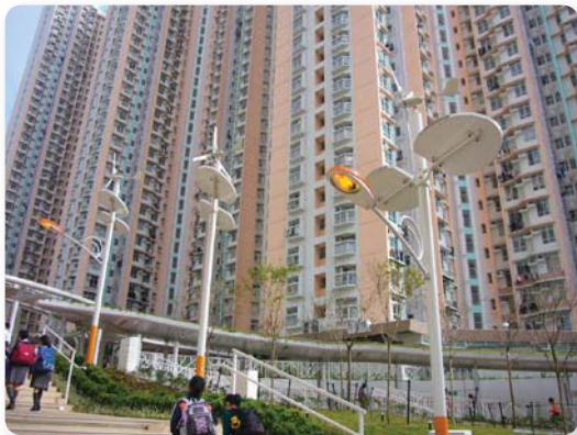
秀茂坪南邨的太陽能 and 風能聯合照明系統
