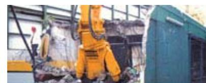
液壓混凝土壓碎機可減少拆卸噪音
