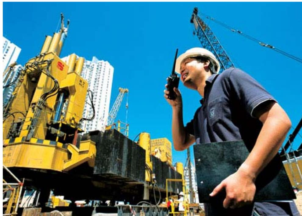
正在測試油壓式送樁技術
