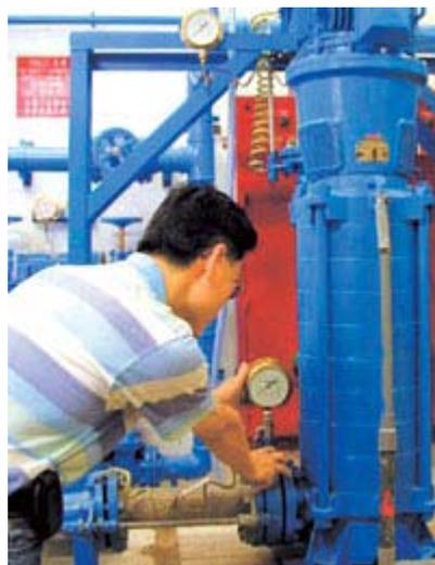
為免居民受到泵房噪音滋擾，我們繼續進行更換水機計劃，改用較寧靜的抽水機。2001/2002年度，擬更換的抽水機共有82個，當中66個已經換妥，其餘16個亦已於2002年4月更換。所有新屋邨已裝設這種較寧靜的抽水機。
