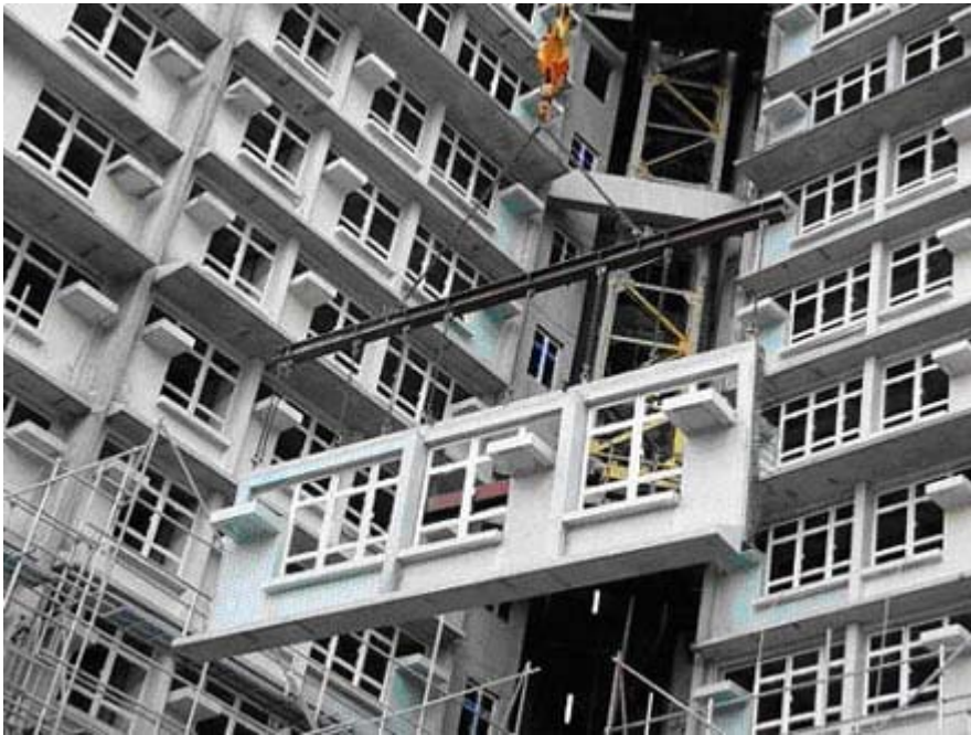
在建屋工程中增加使用預製混凝土組件和預製建築構件
